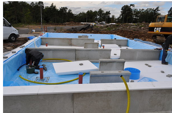
Modern krypgrund under uppförande utan ventilation i grundmur
