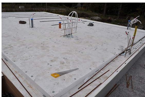
Förberedelse av en grund med isolering av cellplast
