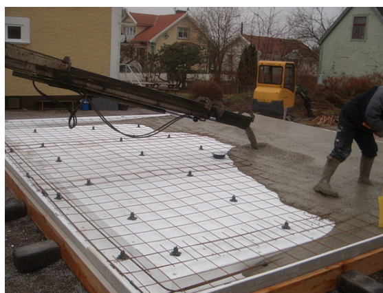
Gjutning av platta på mark över cellplastisolering, här endast ett garage
